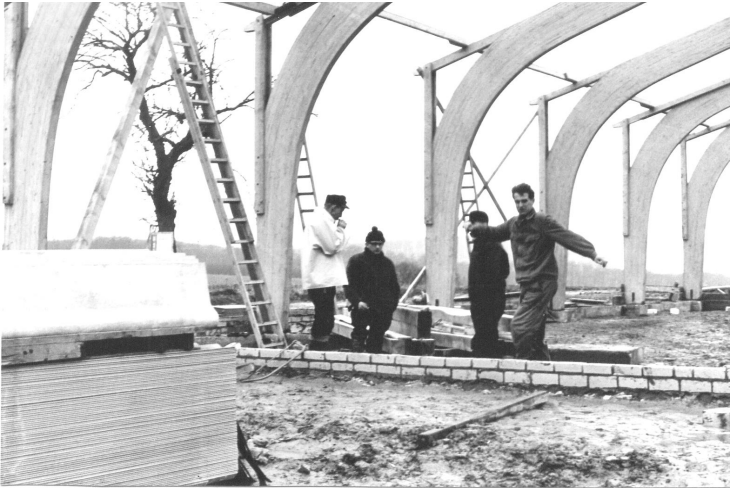
Bau der Flugzeughalle 1970
