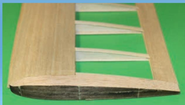
Massiver Randbogen aus Balsa. Außerdem erkennbar sind die nachträglich montierten Rippenaufleimer
